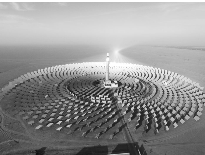
图为位于甘肃敦煌的全球第三座、亚洲第一座可实现24小时连续发电的熔盐塔式光热电站。该电站100%采用太阳能。
