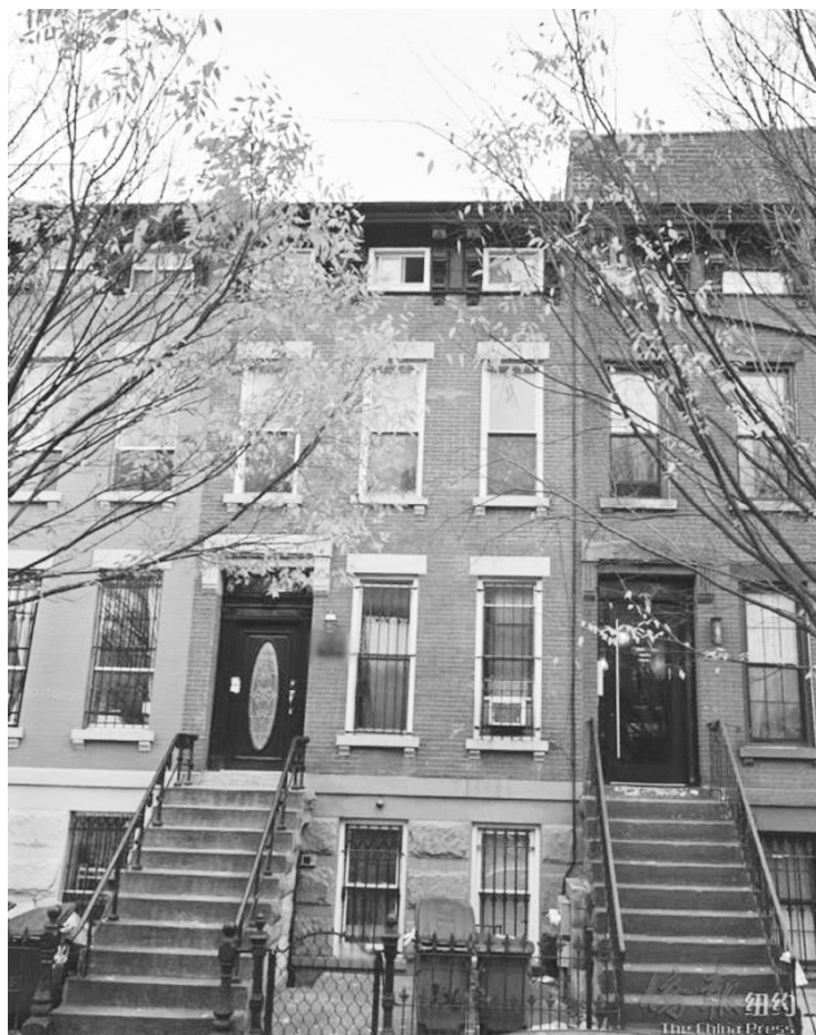
亚当斯位于布碌仑拉菲逸特大道联排屋住宅被人投诉有非法改建。
